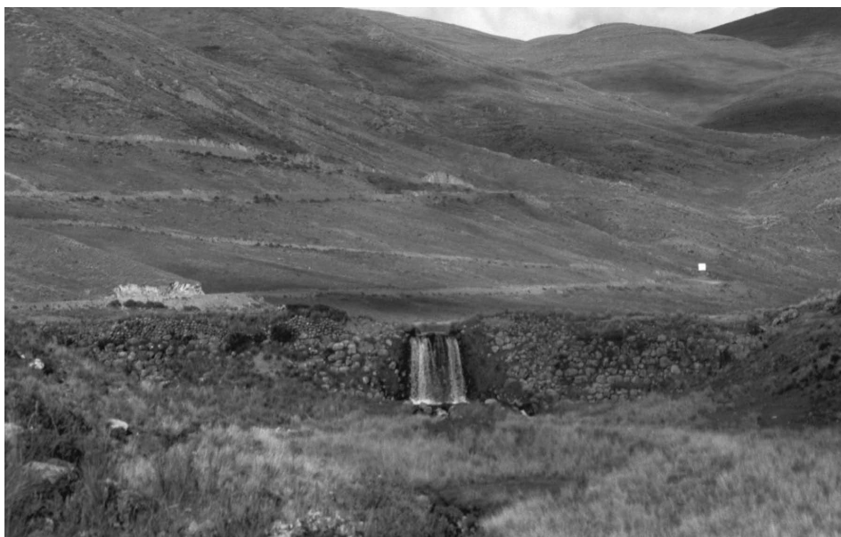
Fig. 24. El río Huinchos actualmente corta la presa de Qullpa qucha. Originalmente, la cascada discurría sobre la roca madre (en la foto, lado derecho), a la cual se encuentran ancladas esta y otras represas de limo del alto Nepeña. Los canales de desfogue ubicados a distintas alturas hacen que el muro actúe como un gigantesco colador reteniendo los sedimentos, que, a su vez, retienen la humedad que sostiene el bofedal
