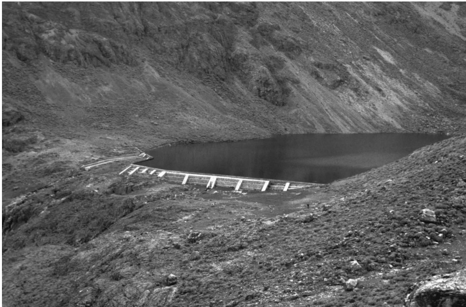
Fig. 19. La presa de concreto de Pacarinancocha, construida sobre las bases de una represa antigua que elevaba el nivel de agua de una laguna de altura, presenta rajaduras preocupantes. Su nombre, “laguna del origen” o “del surgimiento”, sugiere una importancia simbólica de larga data (distrito de Pamparomás, provincia de Huaylas, Perú).
