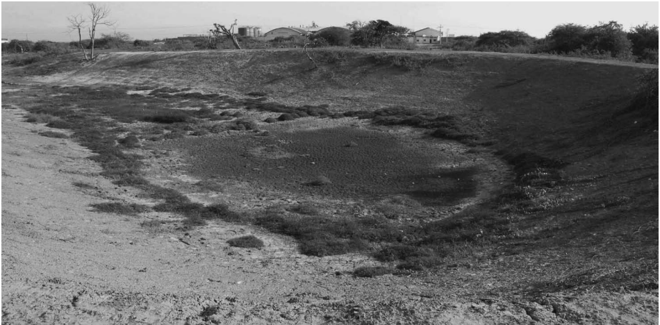
Fig. 14. El fallido rediseño de la albarrada de Enyamuco —para crear áreas de esparcimiento en la comuna de Manantial (cantón Santa Elena, provincia del Guayas, Ecuador)— implicó la remoción con maquinaria pesada de las capas de sedimentos arcillosos asentadas a lo largo de siglos de trabajo manual, así como de buena parte de la vegetación arbórea
